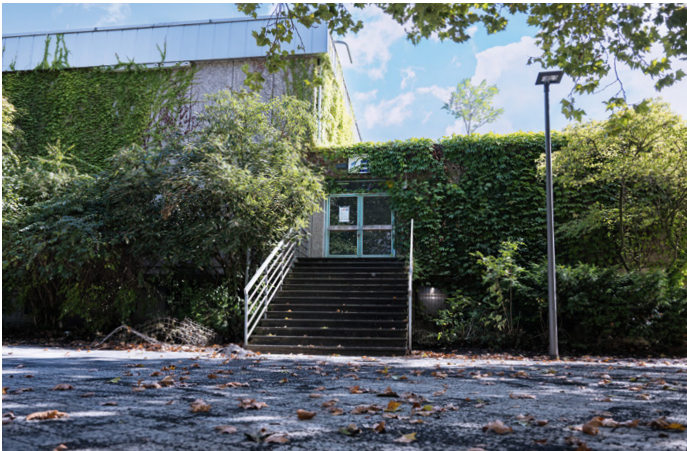
In die Jahre gekommen: Die Sporthalle des Lessing-Gymnasiums in Düsseldorf. Hier wurde allerdings schon ein Solardach installiert
