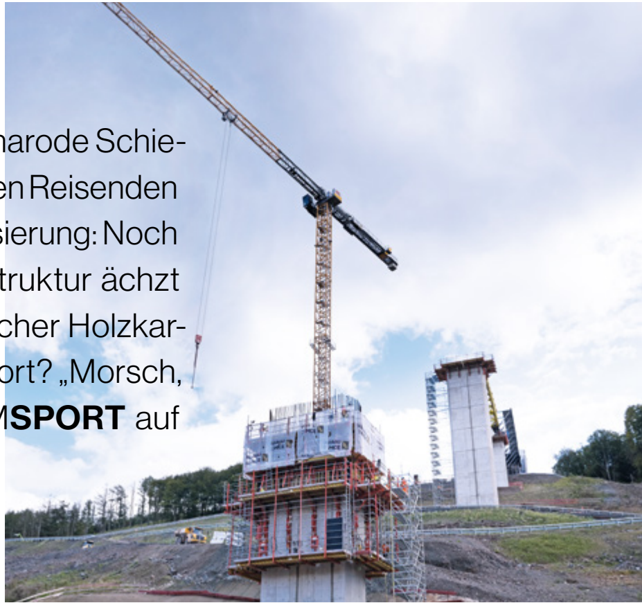
Der Neubau der A45-Brücke hat begonnen
